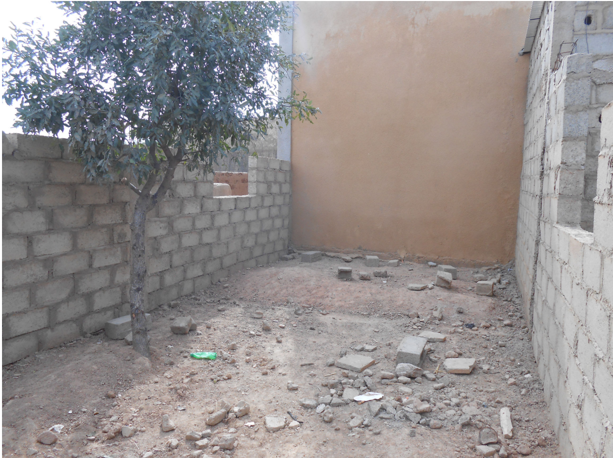
Local informatique en cours de construction à Nioko 2, Ouagadougou, Burkina Faso
